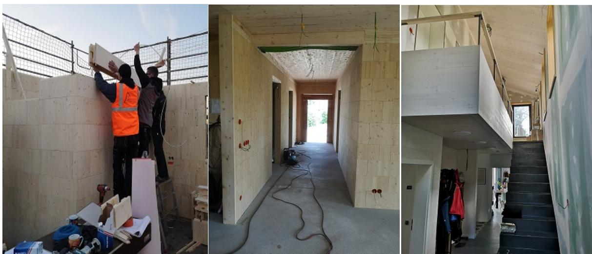
Gleichzeitig kann mit dem Einsetzen der Türen und Fenster begonnen werden. Diese werden mit vorgefertigten Systemteilen dauerhaft dicht in die **STEKO** Wände eingefügt.
