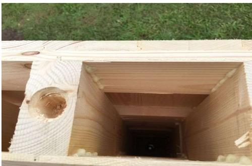
Dadurch können die einzelnen Modul-Kammern sicher mittels Aluminium-Einblasrohr von oben je Geschoß gedämmt werden. Ergänzend geht auch eine Drehdüse im nachträglichen Einsatz.
