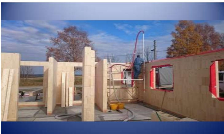
Als oberer Abschluss dient der Einbinder, welcher schon über jeder zweiten Kammer zum Einblasen der Zellulose-Dämmung vorbereitet wird – Musterstück in Versetzung.
